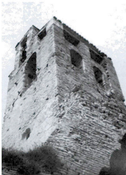
FIGURA 11. Campanar, abans de la restauració de 1996 (c. 1972, fotografia F. Fité). En primer terme, hom pot veure el contrafort afegit el 1923 per recolzar la zona absidal.
